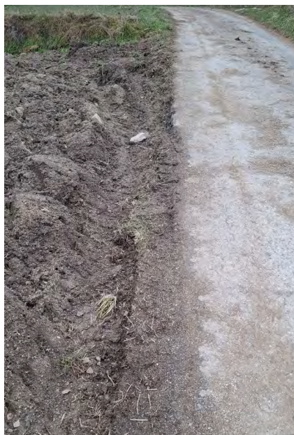
Fotos links und rechts: beschädigte Bankette
